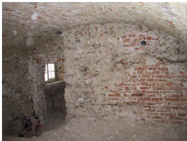
Die Umbauarbeiten im Pfarrhof gehen zügig voran.
