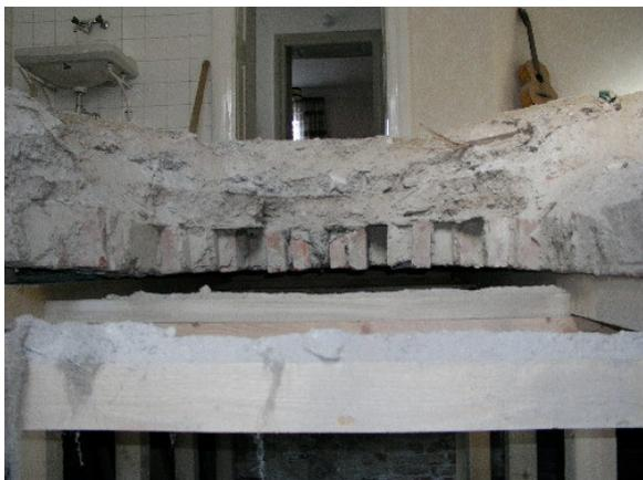
Das alte Gewölbe im hinteren Bereich des Pfarrhofes war sanierungsbedürftig. Aus diesem Grund wurden Unmengen von Schutt aus dem mittleren, bereits durchhängenden Teil des Gewölbes entfernt.
