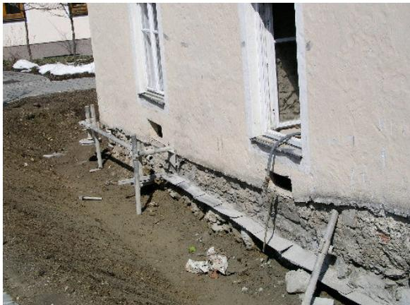
Die dicken Pfarrhofsmauern wurden mit erheblichem Aufwand trocken gelegt. Das Mauerwerk enthält etliche Granitsteine, die nicht zu durchschneiden waren.
